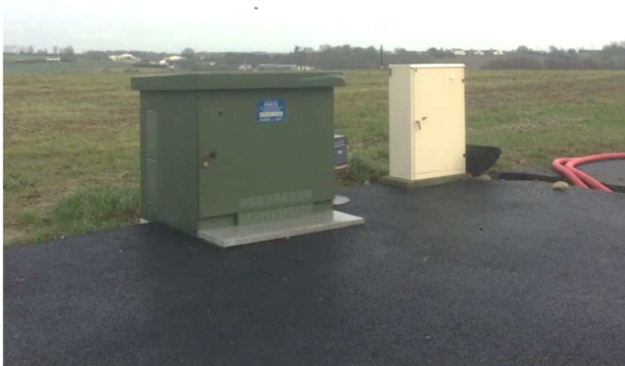
Figure 41 : Compteur électrique à l'entrée du site
