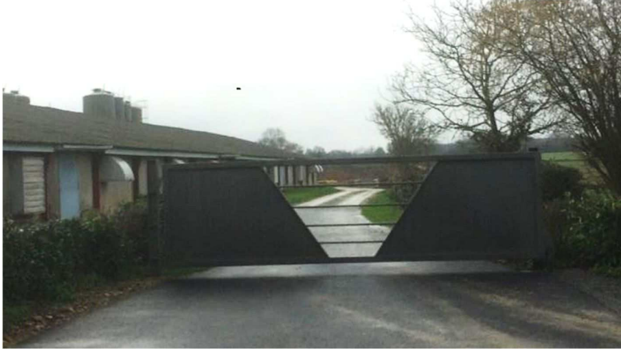
Figure 37 : Un des portails d'accès au site
