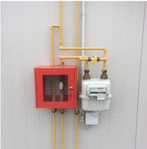
Figure 40 : Vannes barrage devant les bâtiments d'élevage
